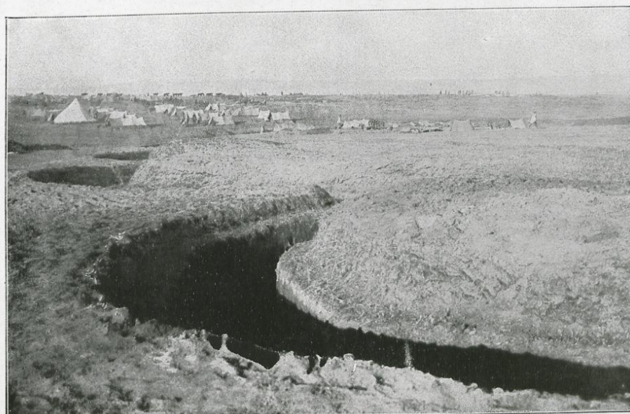
Une des lignes de tranchées qui, dès les premiers jours de janvier, formaient à Salonique un solide rempart moderne. En arrière, les tentes des travailleurs.
