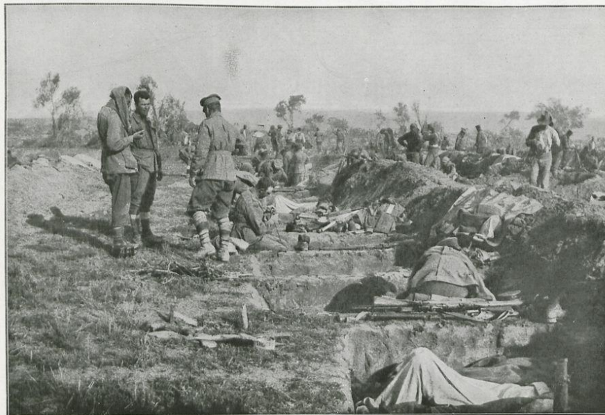
Les campements britanniques offrent un aspect différent : au lieu de dresser des tentes, les Anglais creusent des fosses individuelles peu profondes, où ils se couchent à l'abri d'un talus fait des terres excavées.
