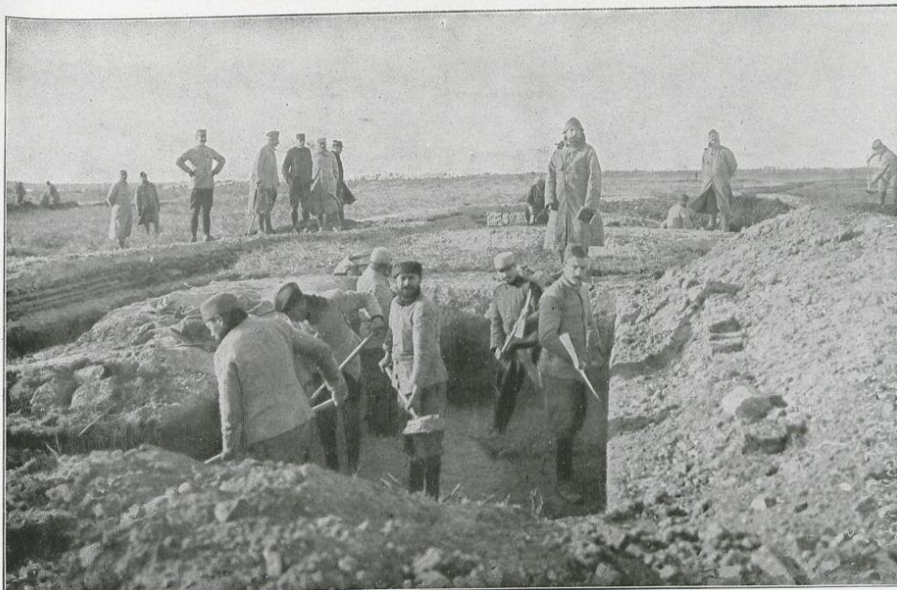
La ville et le camp de Salonique sont mis immédiatement en état de défense. Sous les yeux du général Sarrail, que l'on reconnaît au second plan, nos soldats ont momentanément déposé le fusil pour la pioche et remuent activement la terre.
