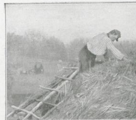
Un « couvreur » au travail installe un toit de roseaux.
