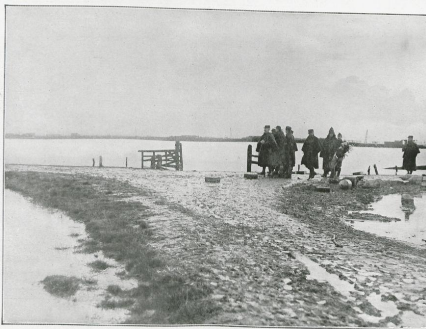
L'inondation protectrice sur la rive gauche de l'Yser.
