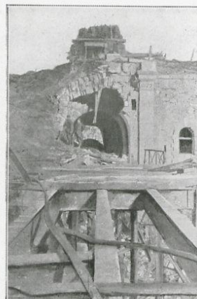
L'état de la même entrée à la fin du bombardement.
