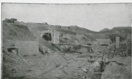
Les effets, sur le fort, des obus de 280 et de 305 millimètres.
