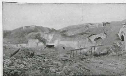
Les effets, sur le fort, des obus de 280 et de 305 millimètres.
