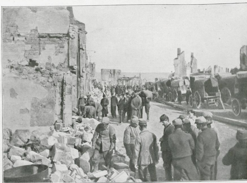
Juste retour des choses : des Allemands prisonniers déblaient les rues de la ville que les leurs ont détruite.
